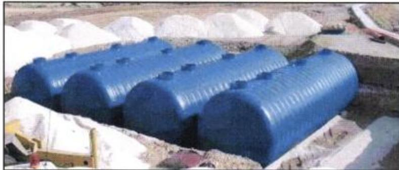
Figura 15. Tipología de los depósitos enterrados instalados
