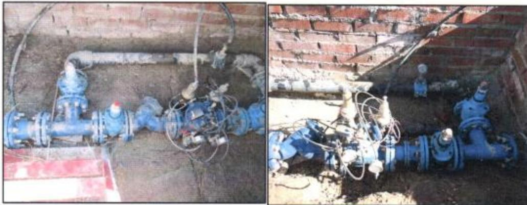
Figura 11. Válvulas reguladoras de presión de doble consigna
